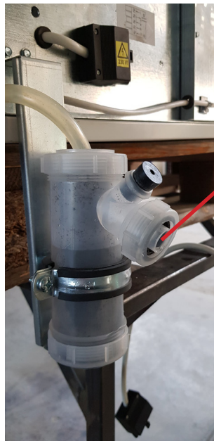
5. Obrázok: Inštalácia sifónu na odtok kondenzátu
